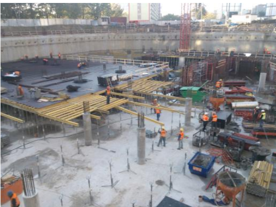
Zdjęcie z realizacji inwestycji
